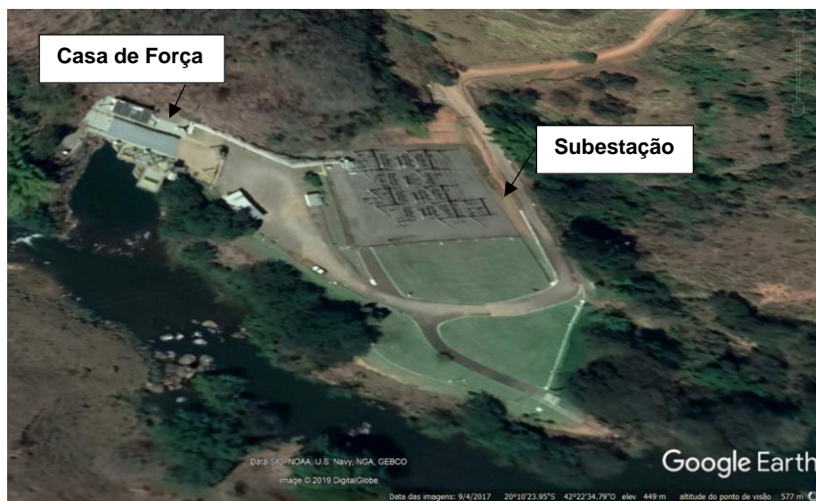
Figura 5 – Localização da Casa de Força e Subestação da PCH Túlio C. de Melo
