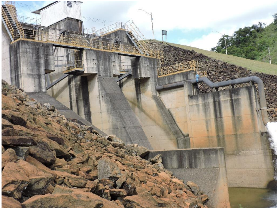
Figura 2 – Vertedouro da PCH Túlio Cordeiro de Melo
